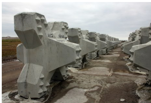
Par leur capacité à s'imbriquer les uns aux autres, les accropodes offrent une résistance équivalente à des blocs rocheux beaucoup plus volumineux. Ils sont régulièrement utilisés dans le monde pour la protection des ouvrages maritimes.
