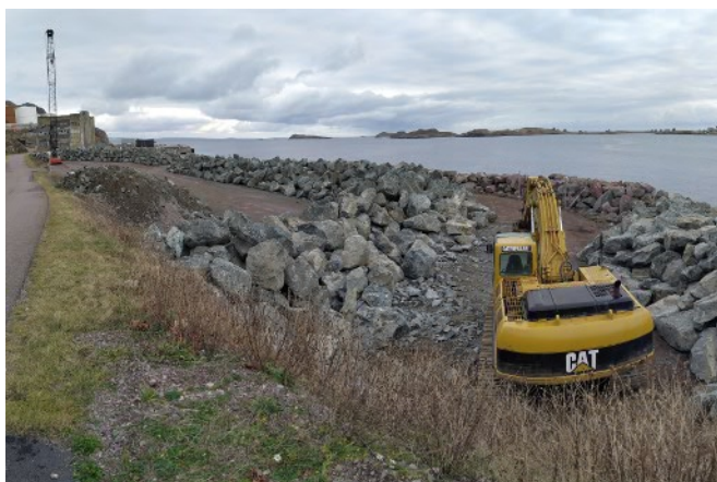
3200 tonnes d'enrochements constitueront la protection du terre-plein qui sera surélevé d'environ 1,5 m.
